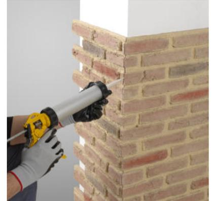
Una vez estén los paneles colocados recubrimos con masilla los agujeros donde se encuentran los tornillos y la junta de los paneles.
