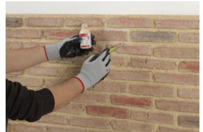
Dejamos secar la masilla durante aproximadamente 24 horas (este tiempo dependerá de la temperatura del lugar de colocación de los paneles) y retocamos las zonas enmasilladas con pintura para juntas Bricopol.
