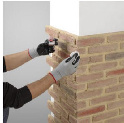
Dejamos secar la masilla durante aproximadamente 24 horas (este tiempo dependerá de la temperatura del lugar de colocación de los paneles) y le damos los retoques necesarios a las piedras o ladrillos con la pintura de retoques. Una vez seca la pintura retocamos las zonas enmasilladas con pintura para juntas Bricopol.
