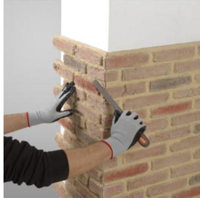
Atornillamos las dos partes del panel del inglete entre ellas con 2 o 3 tornillos (según altura). Expandimos el adhesivo con un pincel dándole la forma apropiada y atornillamos a la pared el segundo panel de la esquina. Si fuese necesario retocamos el ángulo con una lima para igualar las alturas entre paneles.
