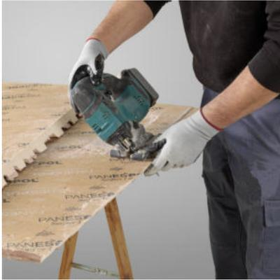
Colocamos el panel en la esquina y trazamos en la parte posterior del panel una línea que nos servirá para hacer el corte en inglete. Con la ayuda de una sierra de calar cortamos a 45° el panel siguiendo la línea marcada anteriormente.
