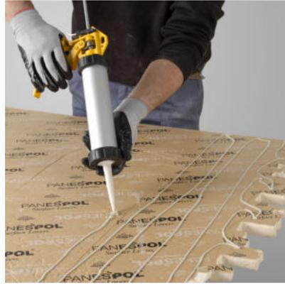
Una vez cortadas a 45° cada parte del panel, aplicamos un cordón de adhesivo en la parte posterior del panel antes de proceder a su fijación. Atención: consultar en caso de instalación en exterior ya que se utilizará un adhesivo específico.
