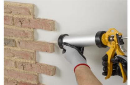
Una vez fijado el primer panel colocamos un cordón de adhesivo en el perímetro del mismo.
