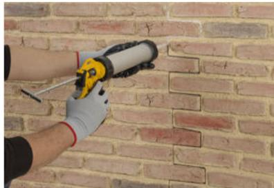
Recubrimos con masilla los agujeros donde se encuentran los tornillos y la junta de unión entre los paneles.
