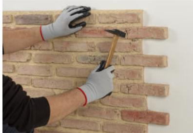
Preparamos previamente tornillos dentro de tacos y los introducimos en los agujeros hechos en panel y pared con la ayuda de un martillo. A continuación, atornillamos hasta introducir el tornillo sin atravesar el panel. Recomendamos atornillar todo el perímetro y la parte central. (Utilizamos aproximadamente una docena de tornillos por m2, el doble si estamos en exterior.)
