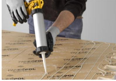
Aplicamos el adhesivo en la cara posterior del panel creando un cordón. Atención: consultar en caso de instalación en exterior ya que se utilizará un adhesivo específico.
