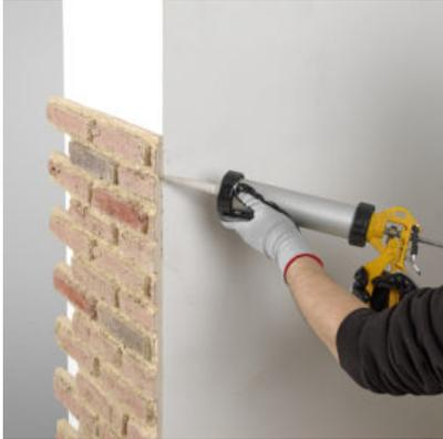
Una vez colocada una parte aplicamos un cordón de adhesivo en el inglete y colocamos el siguiente panel que por su corte en inglete se acopla perfectamente. El panel deberá ejercer cierta presión sobre el adhesivo.
