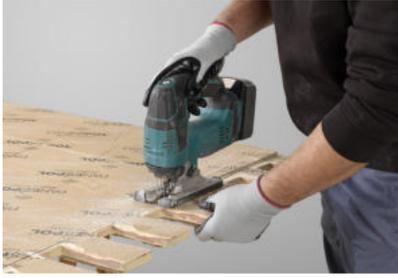
Con una sierra de calar cortamos las puntas del panel para empezar el montaje por una punta de la pared.
